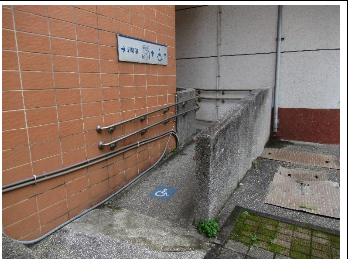
位置：操場往活動中心斜坡道 長寬：1220cm*120cm 143cm(入口處)
